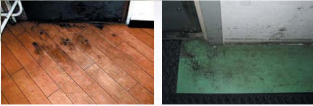
店内やバックヤードに持ち出される油汚れの一般的な例
